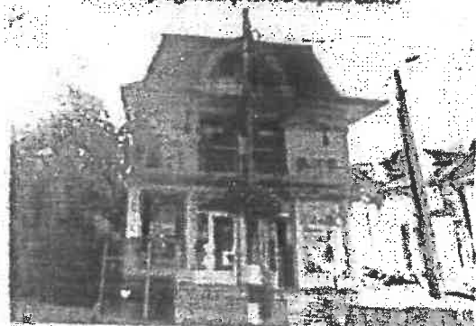
Acoperș inestetic, culori și materiale neadecvate
